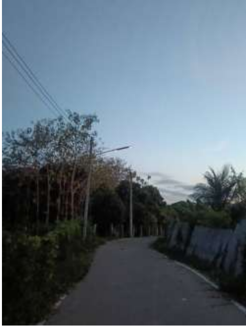
หลอดไฟขาด ซ.8 (สุดซอย)
